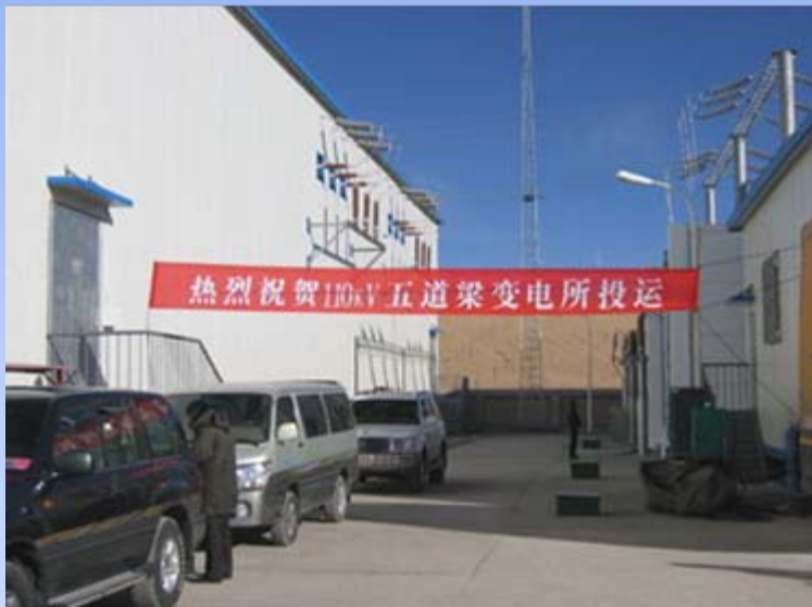
五道梁变电站 2005年12月28日顺利投运
